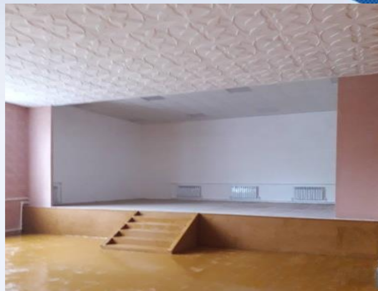
Ремонт Волчанского СДК в с.Волчанка, 2018 г.
